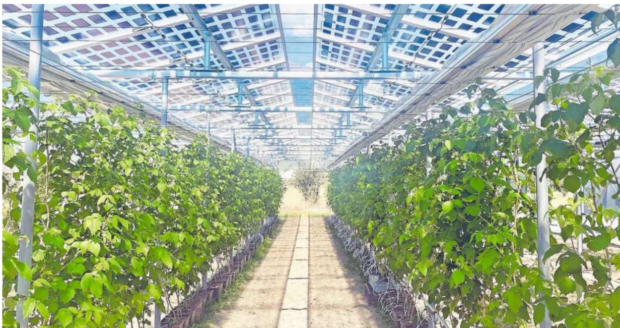
Das Bild zeigt Agri-Photovoltaik über Himbeeren mit semitransparenten PV-Modulen und zusammengezogenem Schirm zur Optimierung des Mikroklimas. Bild: zvg
